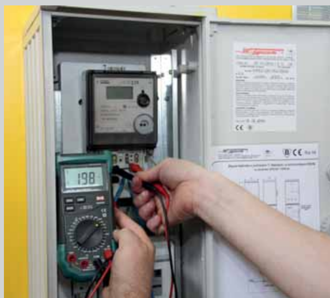
Rys. 10 Po awarii licznik dalej dostarcza energię do odbiorcy.
