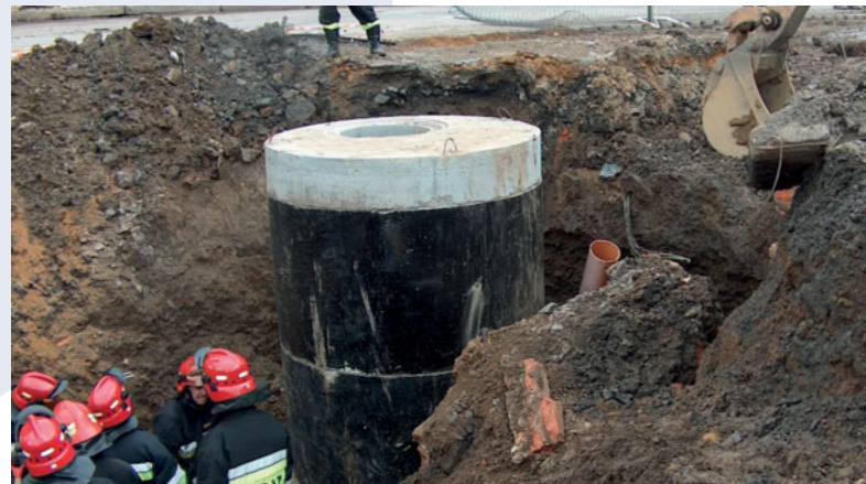
▲ Zdjęcie z akcji ratunkowej przysypanego w wykopie
