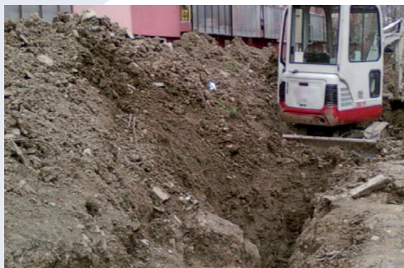
► Zdjęcie z wypadku śmiertelnego - przysypanie w wykopie
