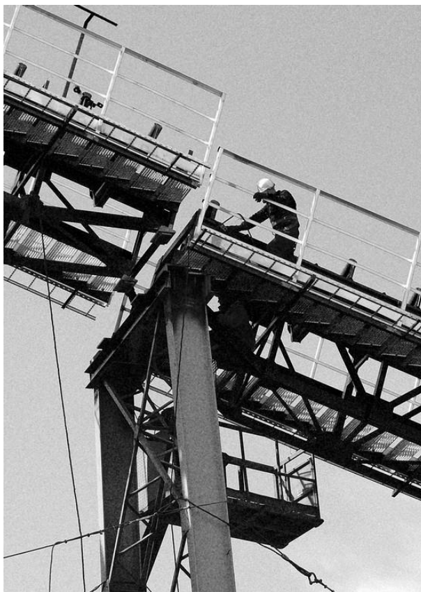
zdjęcie pod tytułem „ Nasuwanie mostu nawęglania - przęsło najwyższe ” autor: Małgorzata Szukalska
